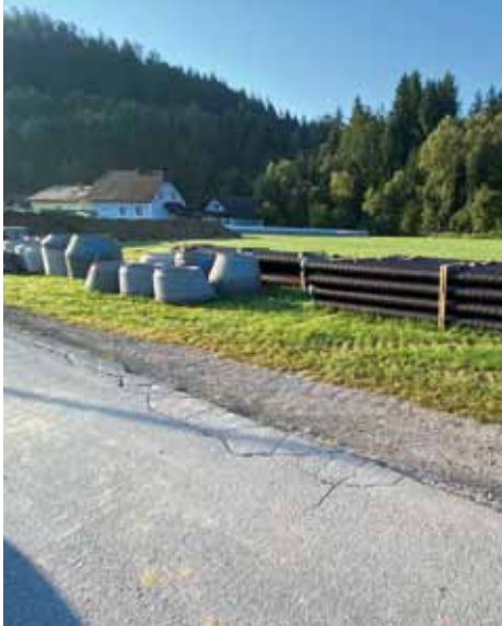
Auch die Straßenoberfläche wird erneuert
