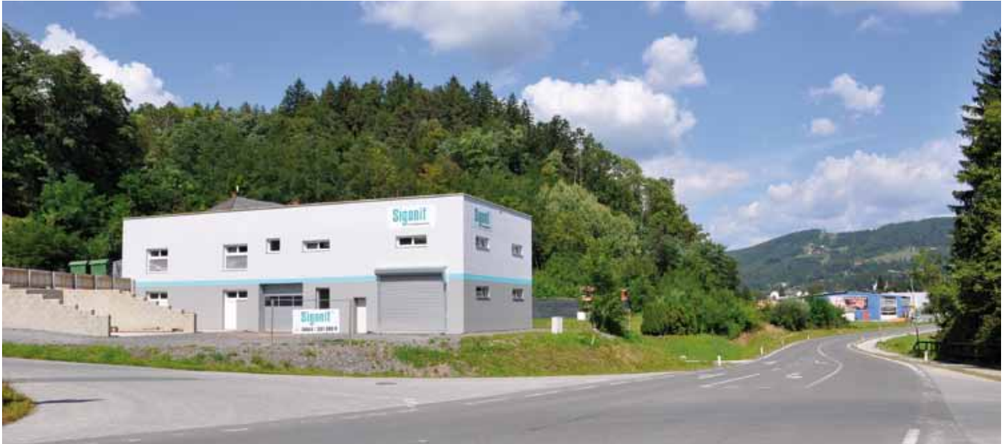
Ein echter Hingucker ist das neue Lager von Sigonit an der Ortseinfahrt von Bärnbach
