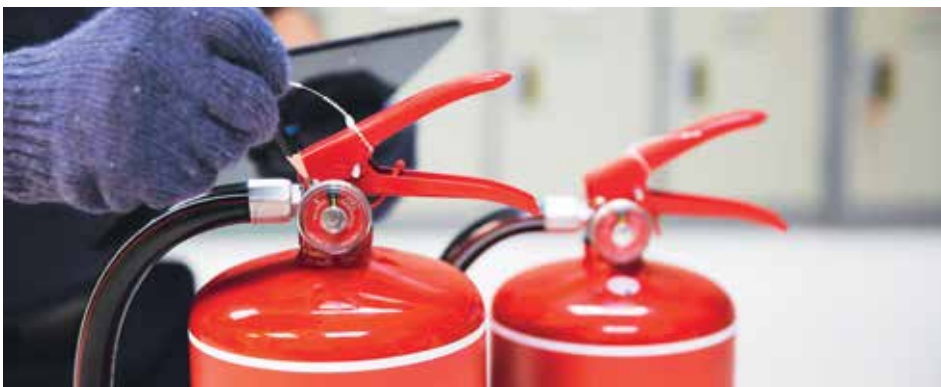
Feuerlöscher müssen in Österreich im Abstand von zwei Jahren überprüft werden
