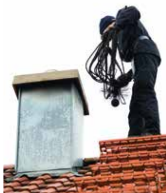
Reinigungs- und Überprüfungsarbeiten von Feuerungsanlagen
