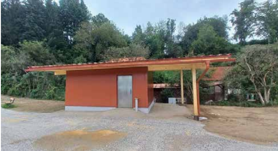
Neues Verteilergebäude garantiert Sicherheit und Qualität der Wasserversorgung
