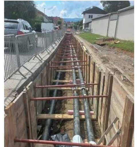
Erneuerung der Hauptwasserleitung
