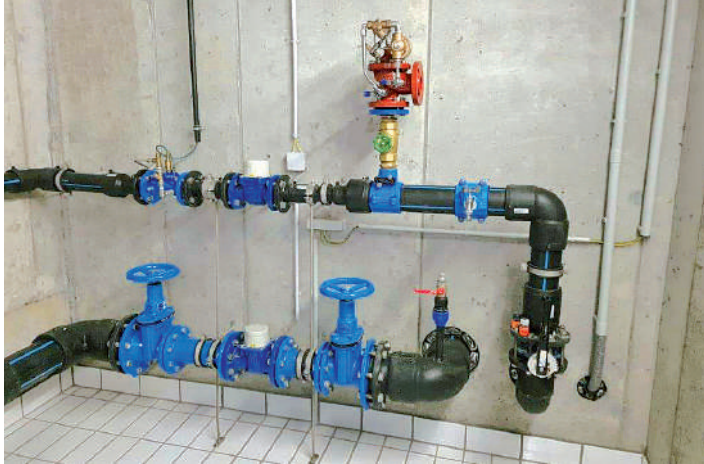
Hochbehälter, Steilstrasse in Afling
