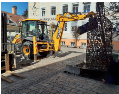
Eine Baustelle zum Beobachten
