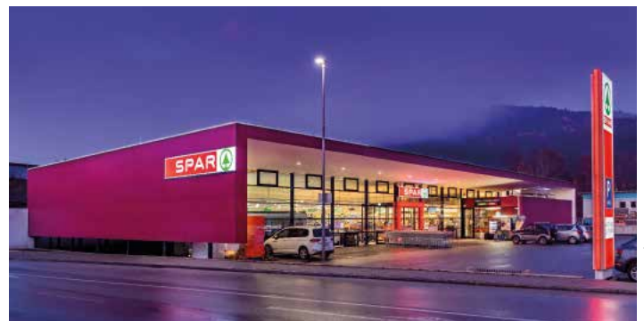
Der Spar-Supermarkt Bärnbach wurde komplett modernisiert
