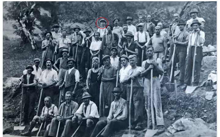
Straßenbau war seinerzeit schwere, händische Arbeit. Hier eine Gruppe bei der Errichtung der Straße in den Oswaldgraben. Matthias Mörth (mit Kreis).
